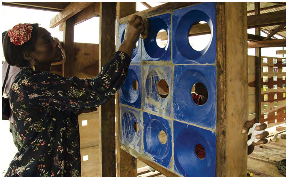
Paolo Cascone + Maddalena Laddaga / CODESIGNLAB, African Fabbers House, Douala, Camerun, 2019. Realizzazione e messa in opera degli elementi modulari di facciata in ceramica
